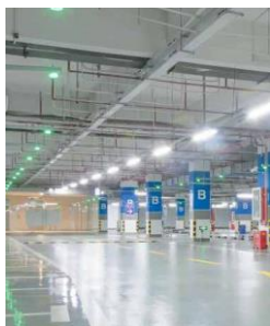
Внутренние помещения/ паркинг
